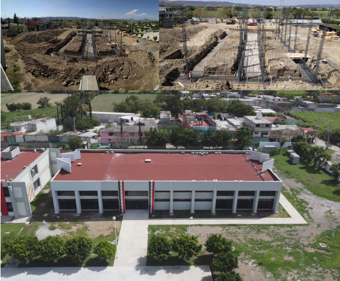
Figura 1. Proceso de construcción y Edificio Académico III terminado.
